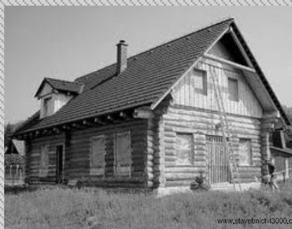
Obr. 58 Vezba rohu úplným rybinovitým přepletováním www.drevostavby-rychle.cz
