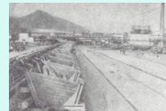
Obr. 43 - Zkraco-vací stanice a sklad klád
